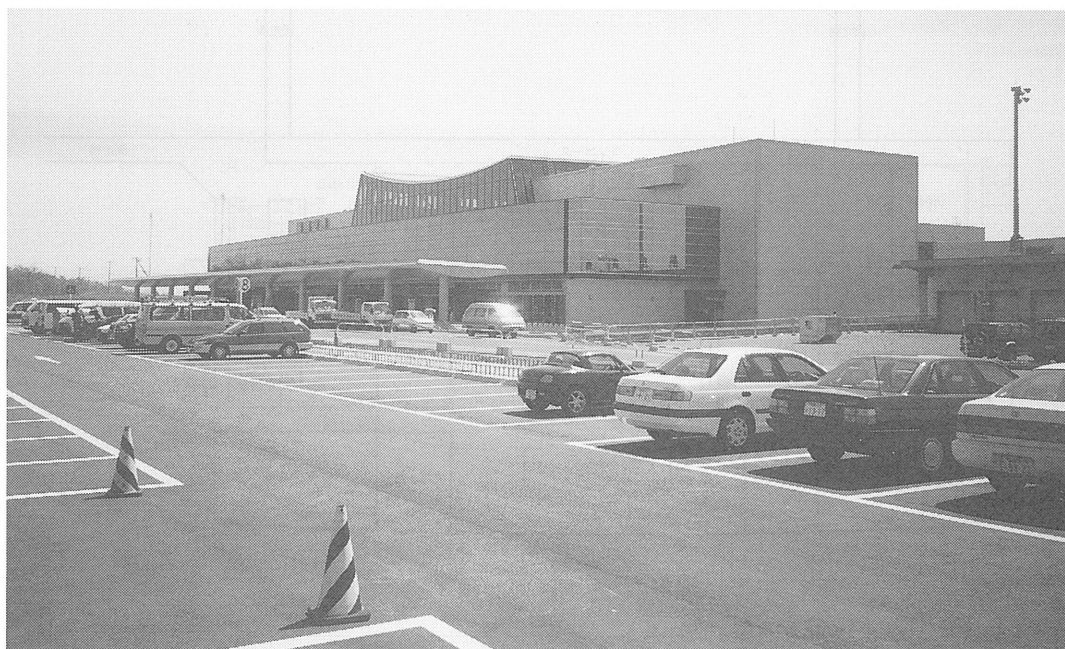
写真-1 ターミナルビル正面外観
