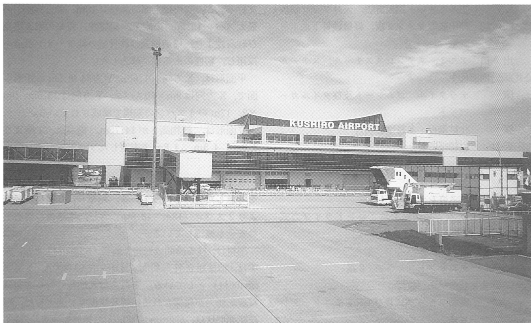
写真-2 ターミナルビル・エアサイド外観
