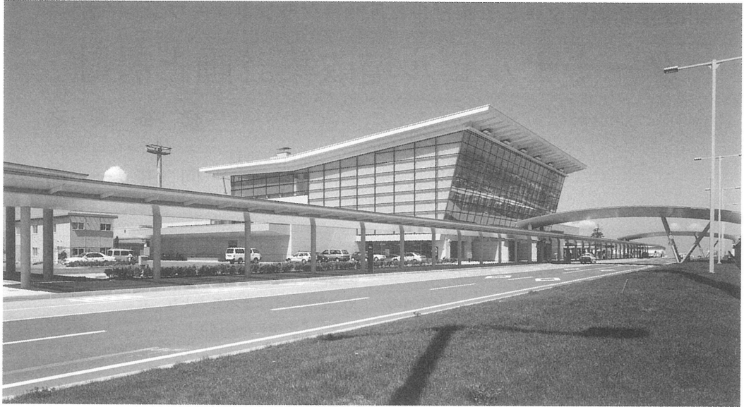
写真-1 カーブサイド外観
